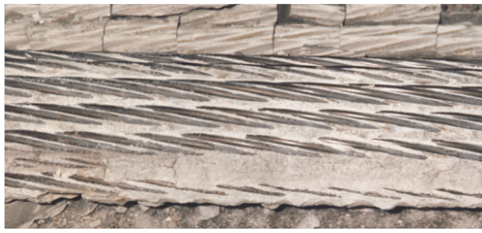
Armature nel calcestruzzo
